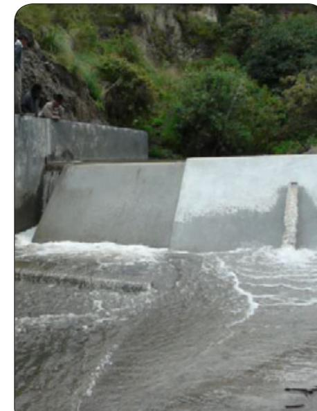
A la izquierda, una presa con tabloncillos de desagüe, vertedero y orificio de caudal ecológico. No se ve la ventana con rejilla para el desvío del agua concesionada.
