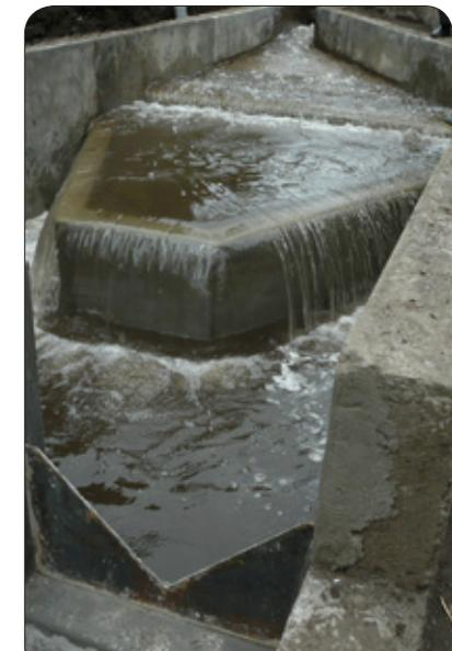
A la derecha, desarenador con tres cámaras de sedimentación. La primera atrapa ripio y vierte agua a la cámara trapezoidal. No se ven las tres compuertas de desagüe. Planchaloma, Cotopaxi, Ecuador.
